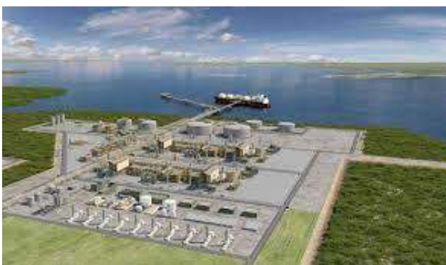
Rovuma LNG Liquefaction plant, Mozambique cceonlinenews.com
