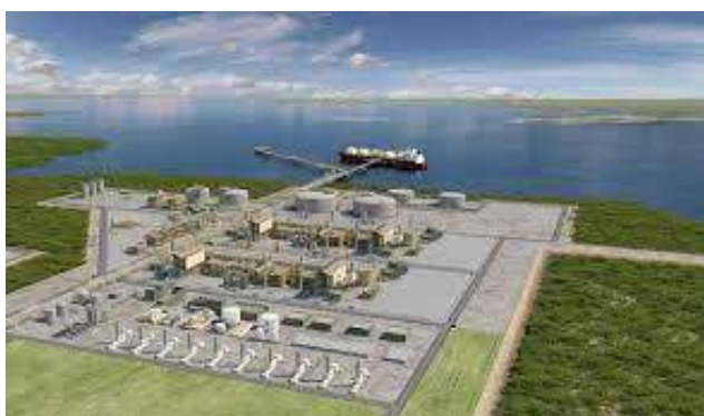
Rovuma LNG Liquefaction plant, Mozambique cceonlinenews.com
